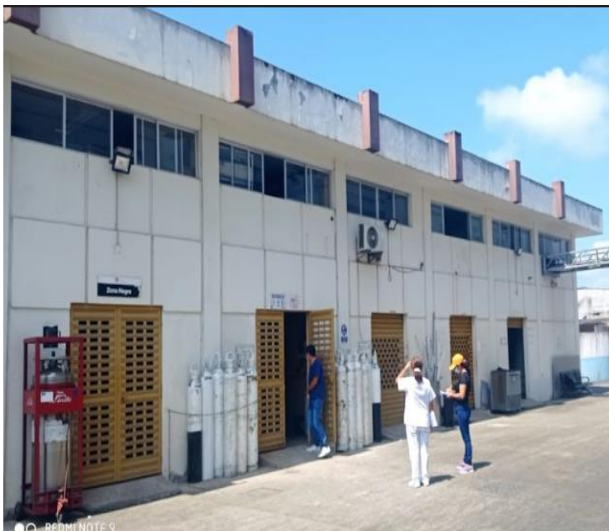
Foto No. 9. Edificación parte posterior (Mantenimiento)
