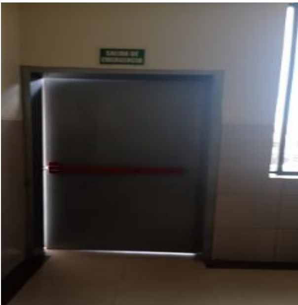
Foto No. 198 – 199 Puerta de escape primer piso alto
