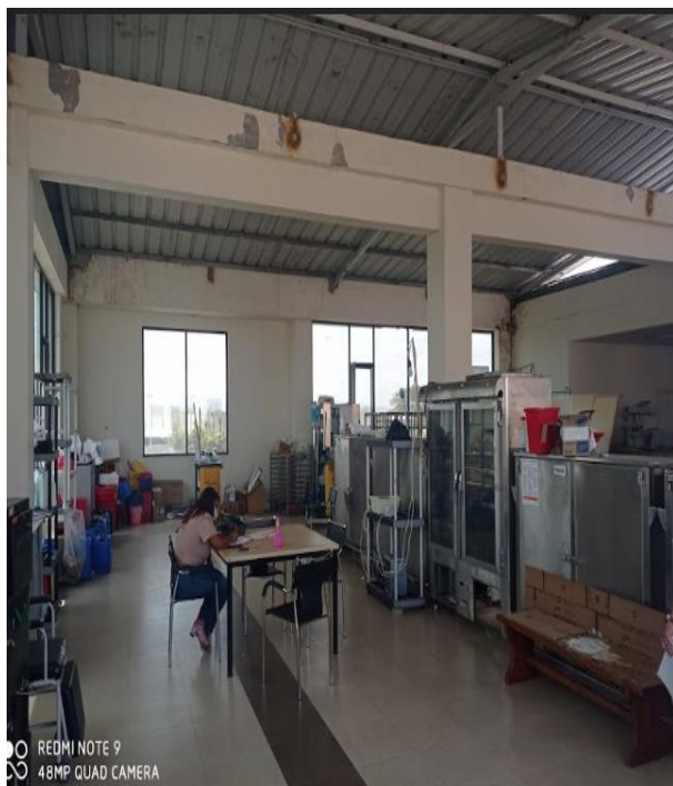
Foto No 58. Área de Mantenimiento
