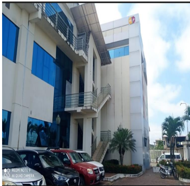
Foto No. 200– 201. Escaleras de emergencia externas
