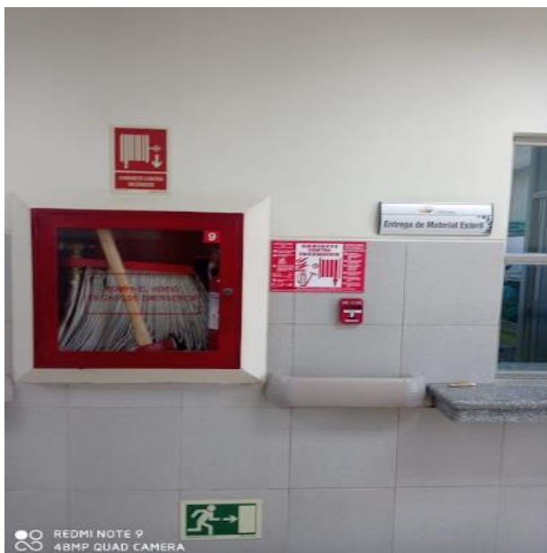
Foto No. 193. Pasillo. Area de entrega de material esteril
