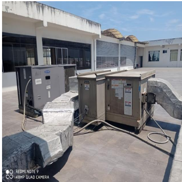
Foto No. 152 – 153. Compresores de aire medicinal
