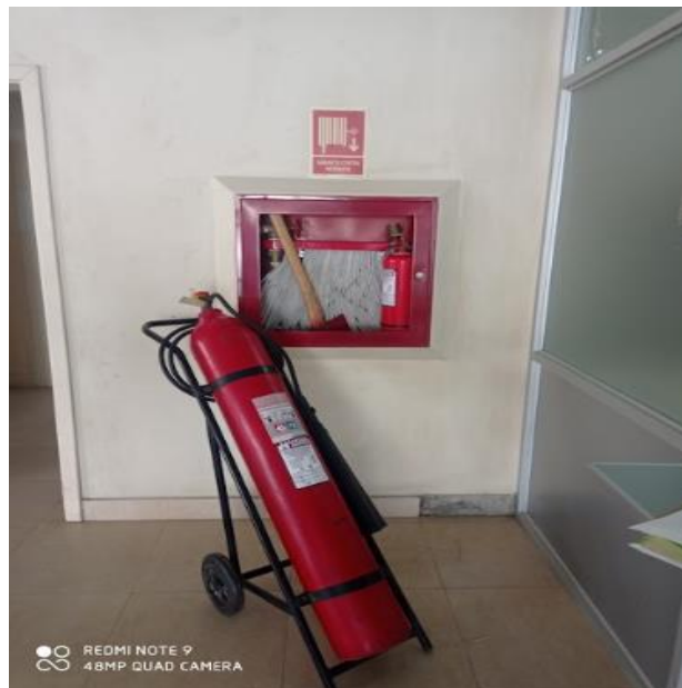
Foto No. 197. Pasillo area de auditorio y bodegas
