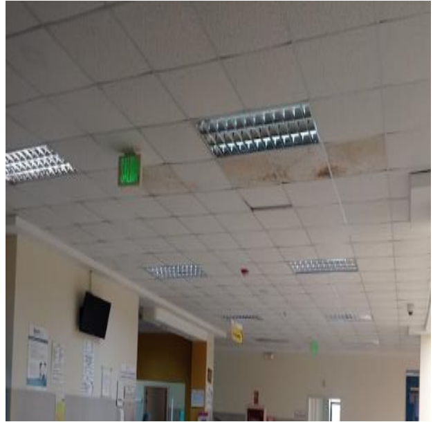
Foto No. 177. Letreros luminosos salidas de emergencia
