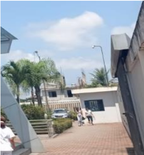
Foto No. 6. Área de garita – e ingreso peatonal
