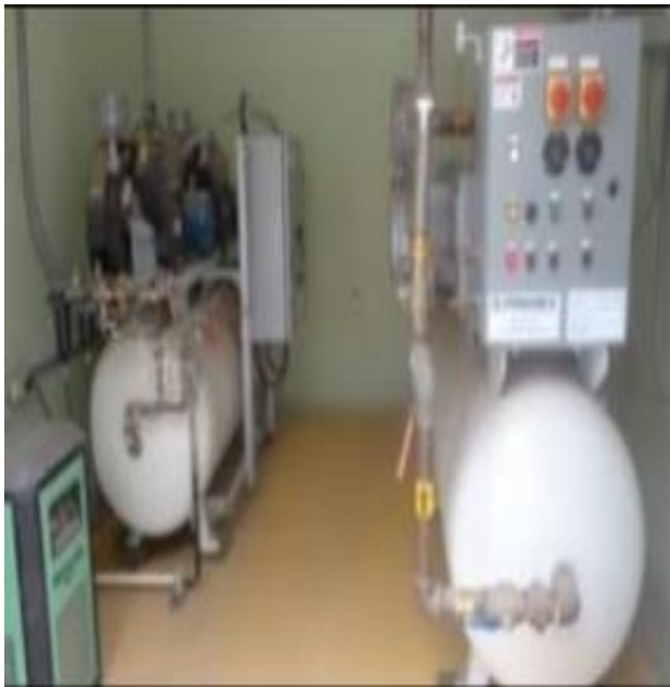
Foto No. 152 – 153. Compresores de aire medicinal
