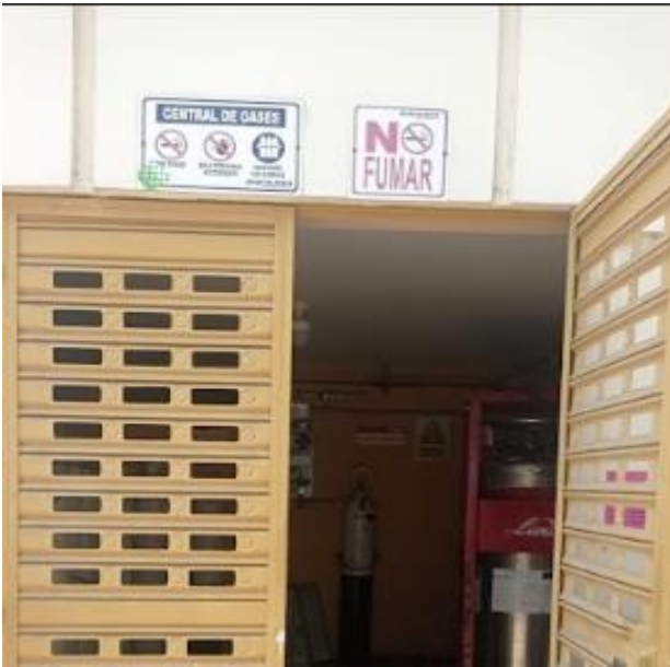
Foto No. 176. Señalética en central de gases
