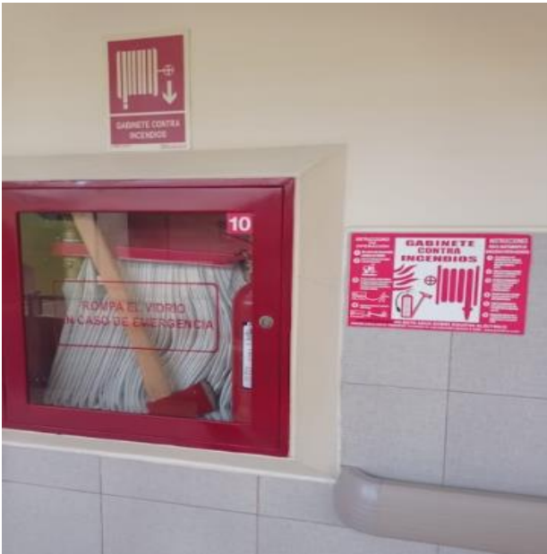
Foto No. 195. Pasillo UCI
